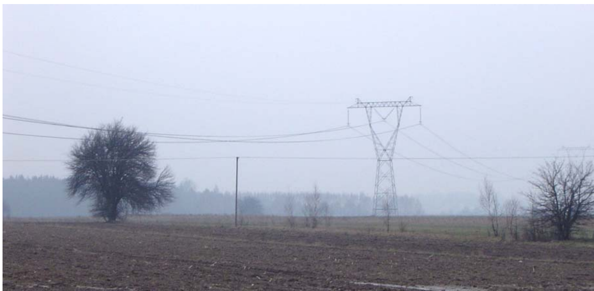
Fot. 5 : Linia energetyczna wysokiego napięcia 400kV w miejscowości Zakrzew
