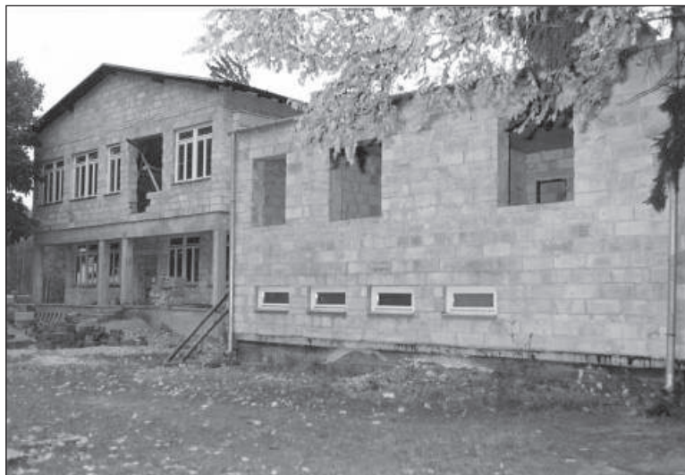
Budowa nowej szkoły – rok 1993. Fot. ze zbiorów SP w Sewerynowie.
